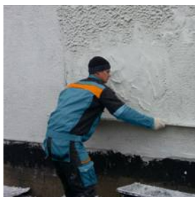
Бескаркасное и бесплитное утепление фасадов
