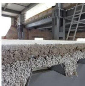
Облегченные стяжки и перекрытия
