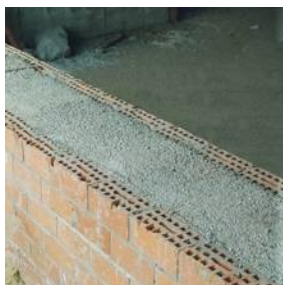
Теплоизоляционное заполнение полых стен
